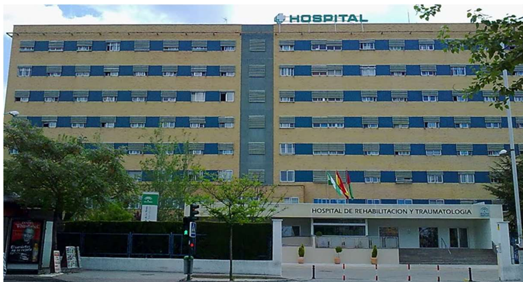
Hospital de Rehabilitación y Traumatología
