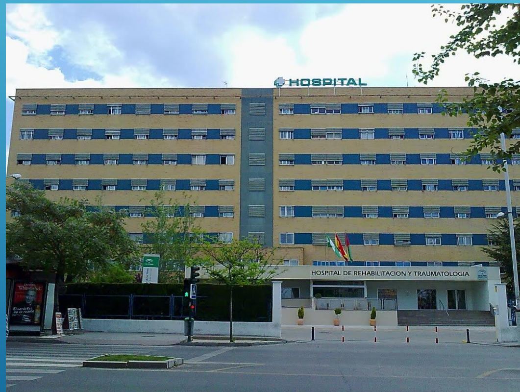
Hospital de Rehabilitación y Traumatología
